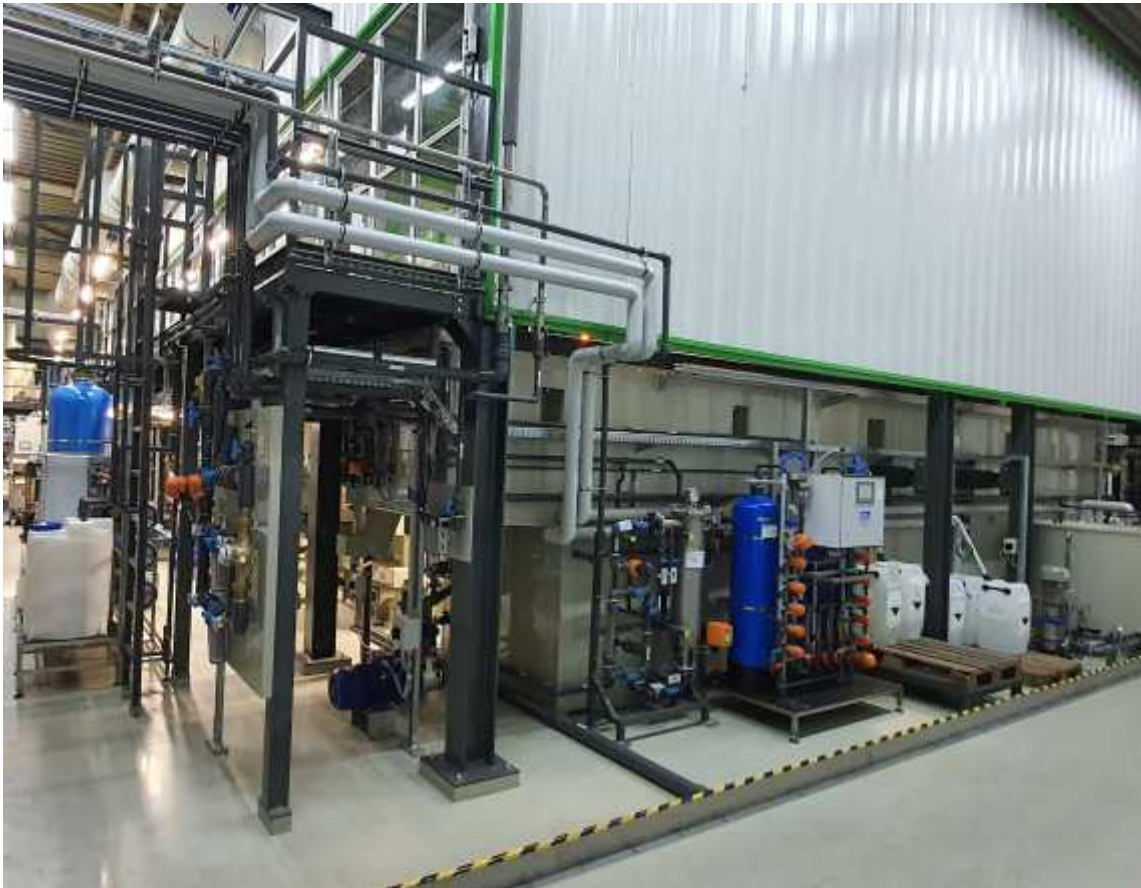
Merítőkádak állványrendszere és a gépészet
